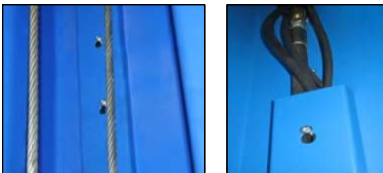
Protezione della condotta dell'olio
