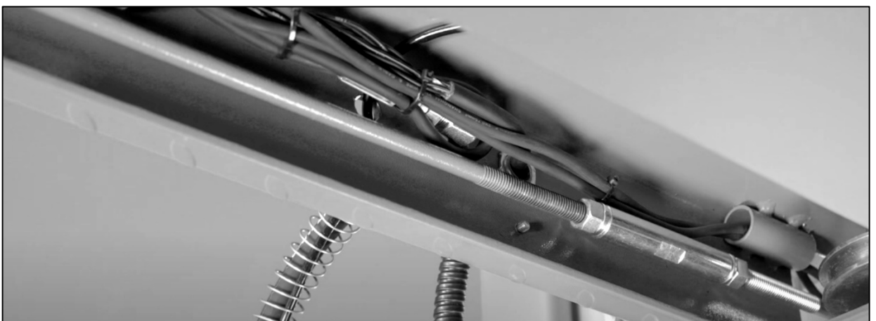
Abbildung: Kabel unter Fahrbahn
